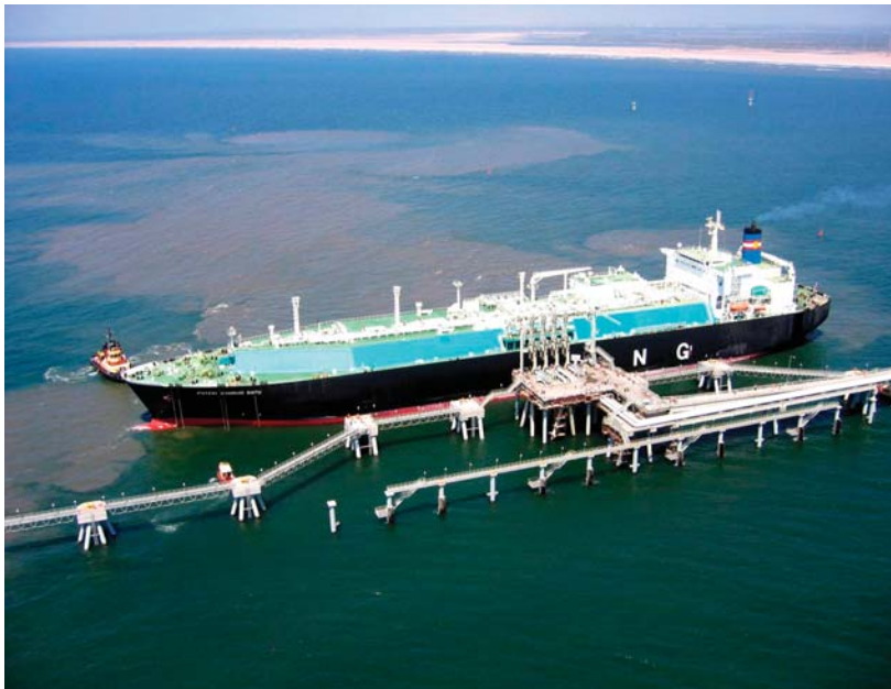
LNG Facilities, Egypt
